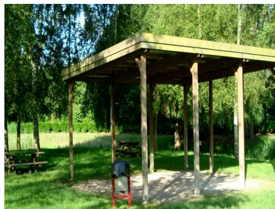
Abri en cas de pluie
